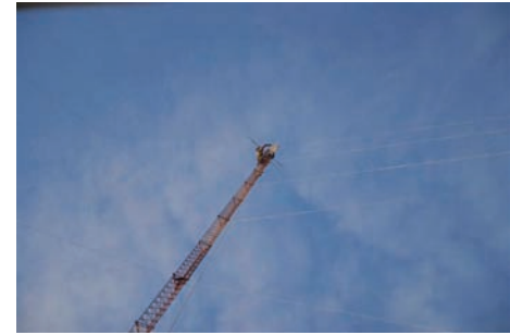
Torre y antena de transmisión de Paj Sachama (“vuelo del monte”), perteneciente a la red de radios del Movimiento Campesino de Santiago del Estero en Argentina (Fuente: Colectivo La Tribu)
